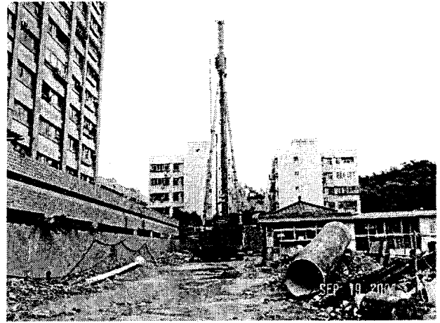
照片 4 高填方之抗滑基樁工程
