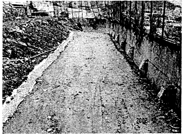
照片 6 五/六區下邊坡加勁擋土牆工程
