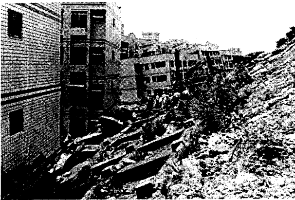
照片 1 災變後之現場狀況
