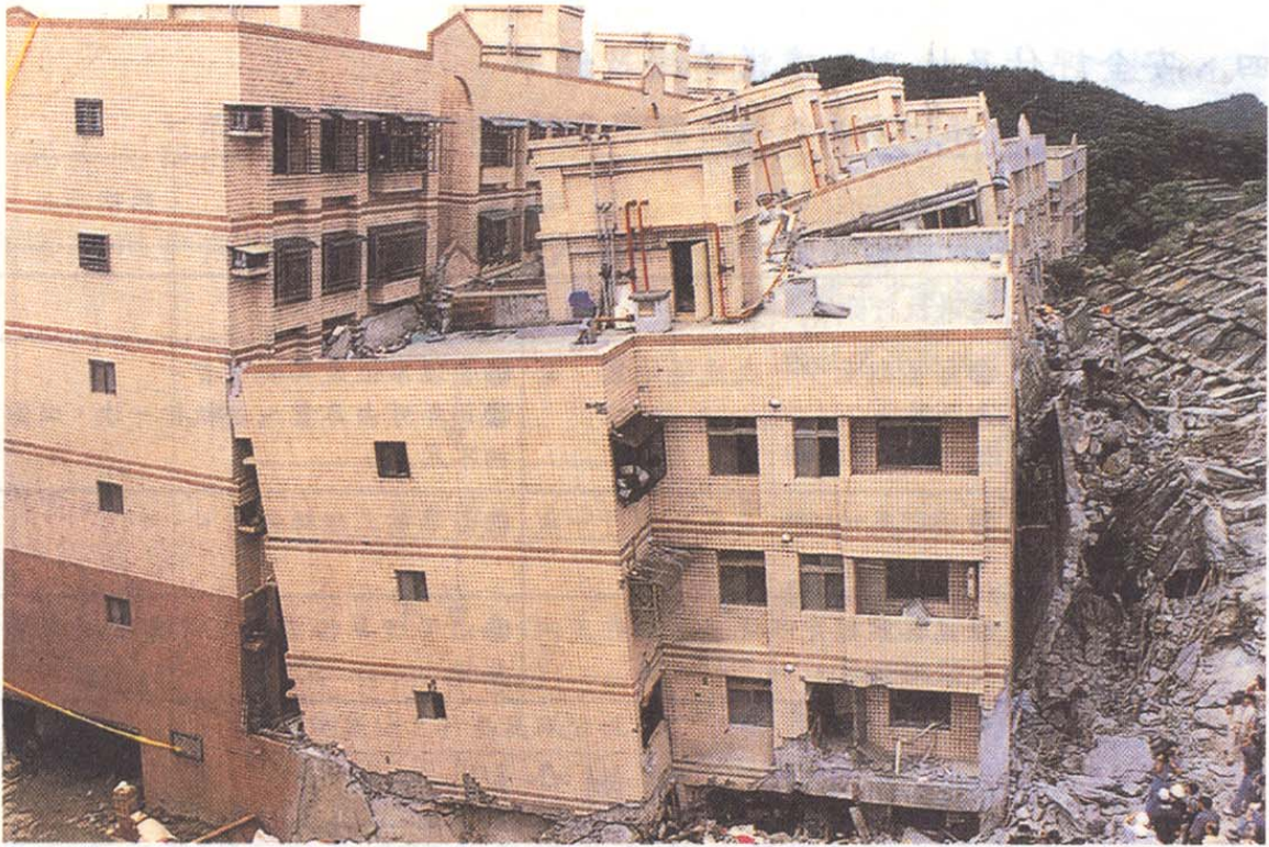
照片-1 林肯大郡社區北側邊坡坍塌災變現場
