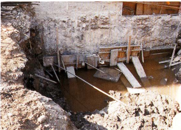
(e) 在基礎四周以混凝土做主要填塞灌漿，並預埋PVC管，做為後續填縫灌漿之用
