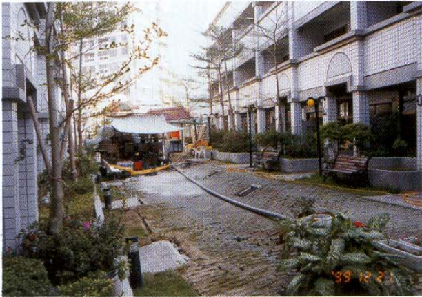
(a) 左側為地上3F、獨立基腳之建築，右側為地上5F 地下1F之建築，兩者地震後行為差異甚大
