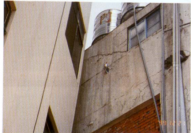
(d) 扶正之建築物及鄰房均設置電子式傾斜儀進行監測
