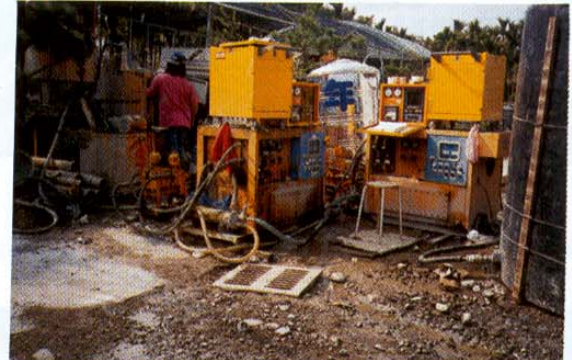
(b) 採用雙重管低壓灌漿工法，灌漿設備包括灌漿機、 流量計
