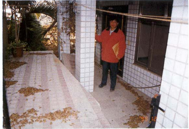
(b) 3F建築物下陷約80cm左右，進行灌漿扶正
