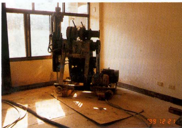
(e) 扶正及補強採用單管灌漿
