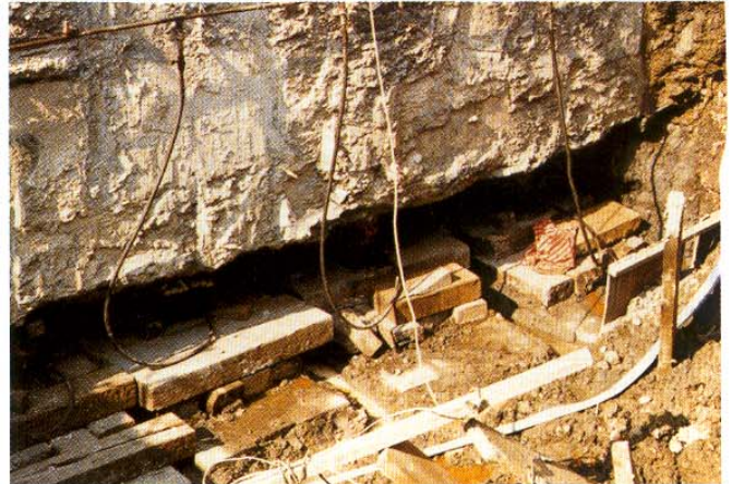
(b) 以油壓千斤頂同步施工，將建築物頂起
