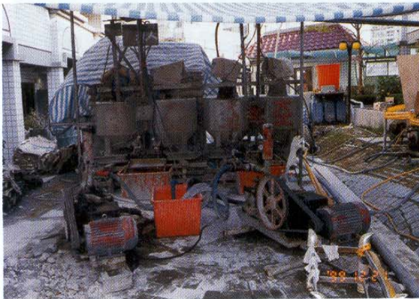
(c) 為進行左側建築之扶正及補強，採用低壓灌漿工法
