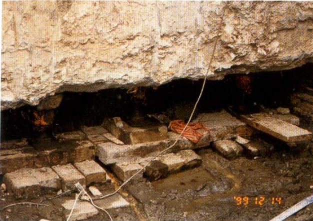
(a) 挖除基礎下方土壤，並設置千斤頂(以地盤改良及枕木做為反力設施)
