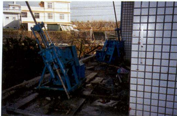
(c) 採用多部灌漿同時施灌，並控制凝固時間
