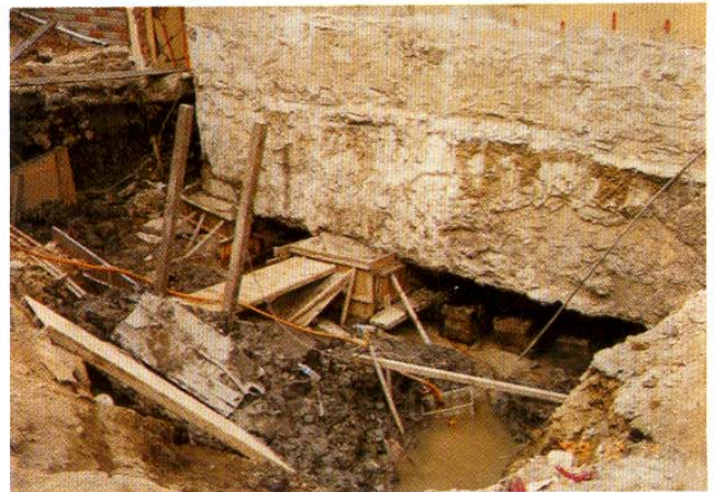
(d) 以頂升工法扶正後再以RC座在原基礎下方補強
