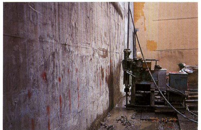
(f) 進行基礎下方最後之填縫灌漿
