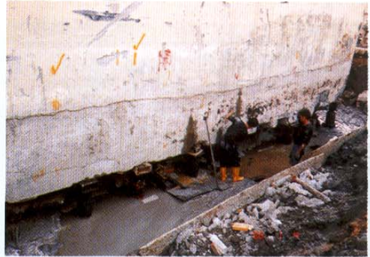
(b) 傾斜估計約1/60，以頂升工法扶正
